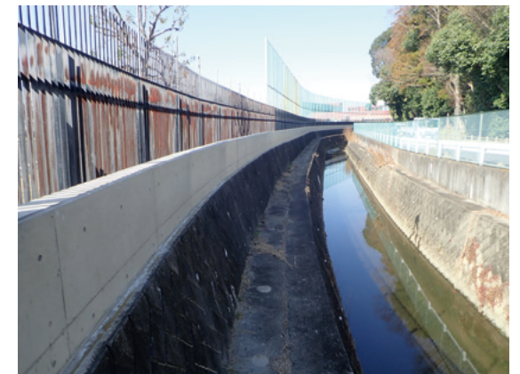
浸水対策工事(コンクリート擁壁嵩上げ)
