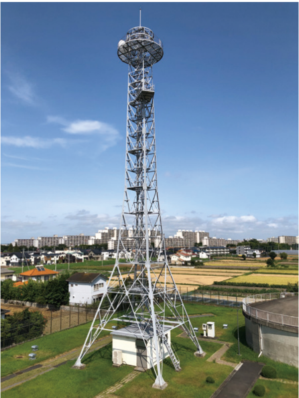
固定無線設備
