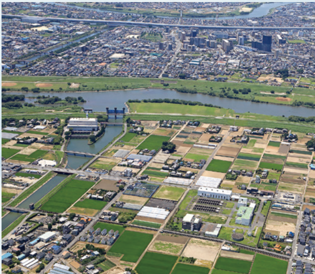
北千葉導水路
