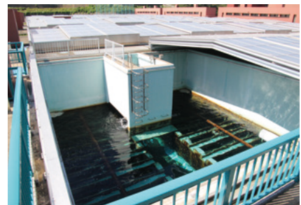
急速ろ過池 砂ろ過層を通過させ細かな濁質分を除去する池。
