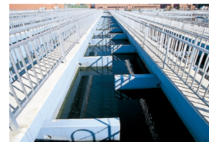
フロック形成池 原水中の濁質分を凝集するため、薬品を添加し攪拌する池。
