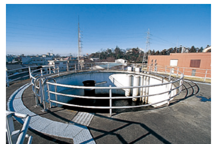
着水井 取水場から導水された原水の水位などを調節する施設。
