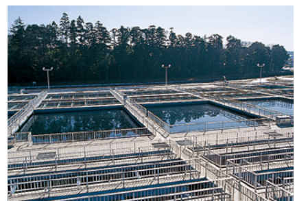
薬品沈澱池 凝集した原水中の濁質分を沈降させる池。沈降した濁質分は掻き集められ、排水処理施設に送られる。
