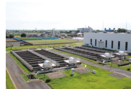
沈砂池 原水とともに流入してきた粒子の大きな砂質分を沈降させる池。
