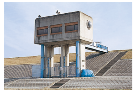
取水門 河川洪水時の流量調節や水質異常時の取水停止のためのゲート開閉を行う施設。
