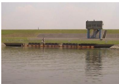
取水口(水道原水の取り入れ口)
