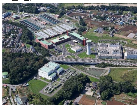
北千葉浄水場(流山市)
