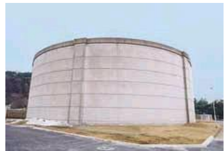
給水地点(構成団体受水槽)
