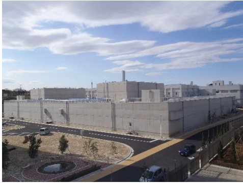
生物活性炭処理施設
