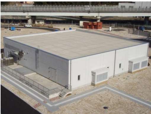
中間ポンプ施設
