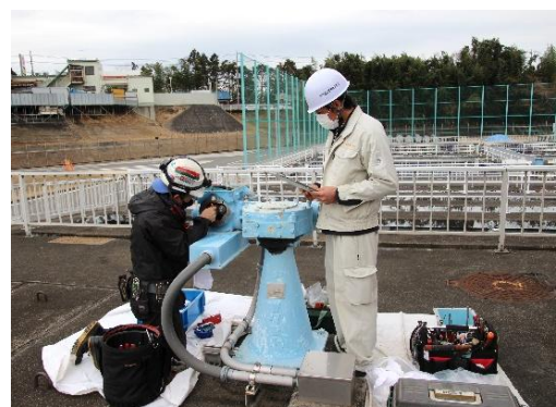
電動弁駆動部の部品交換作業(浄水場)
