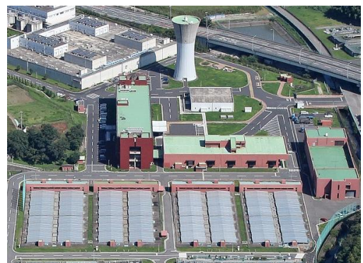
ろ過池の覆蓋（浄水場）
