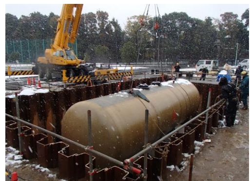
自家発電燃料タンクの増強（浄水場）
