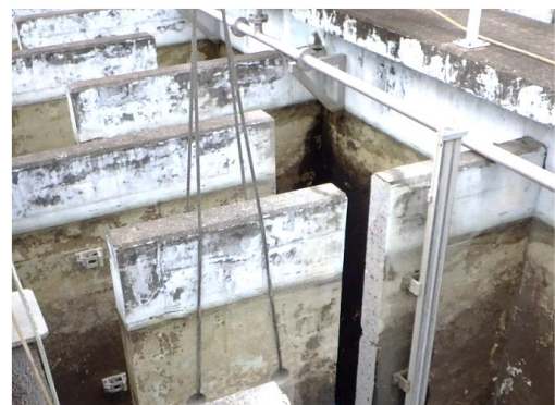
沈澱池迂流壁の改良作業(浄水場)
