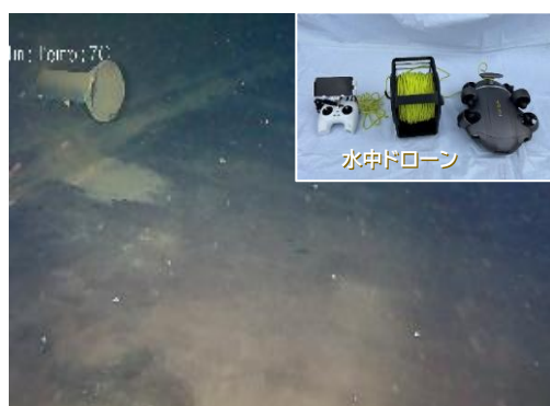
水中ドローンによる構造物の劣化診断 (西初石調圧水槽)
