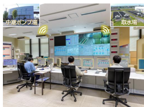
中央監視制御システムによる運転管理 (浄水場)
