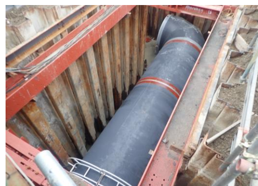
新たな管路の布設
