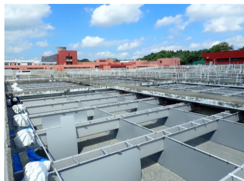
沈澱池の沈降促進対策工事の状況 (浄水場)
