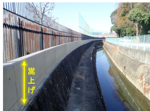
浸水(内水氾濫)対策の状況 (浄水場)
