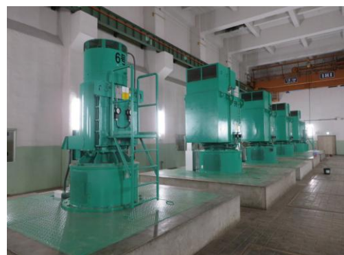
高効率型ポンプ設備への更新 (取水ポンプ電動機)
