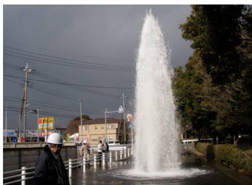
東日本大震災による補修弁の破損 (流山市上新宿地先)
