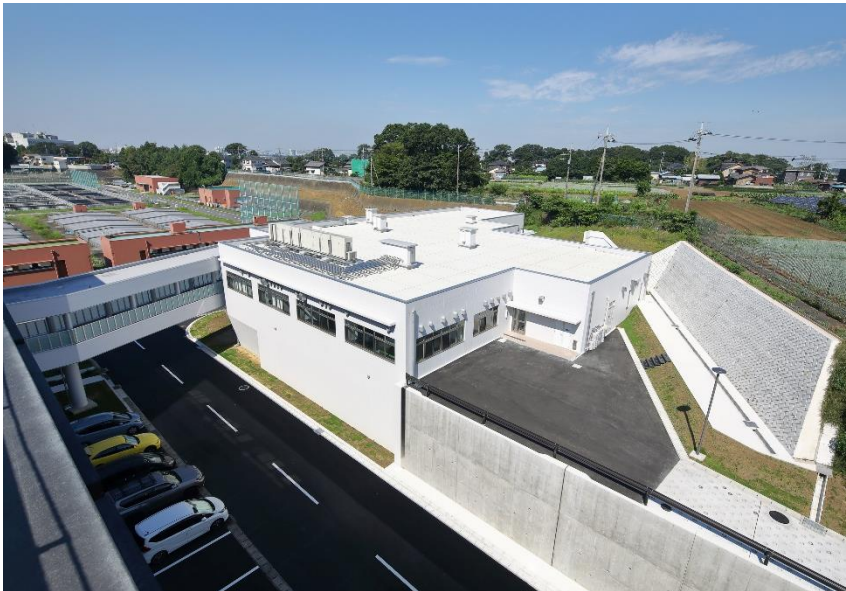
水質試験棟（令和6年6月完成）
