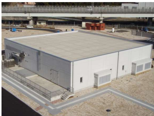
中間ポンプ施設
