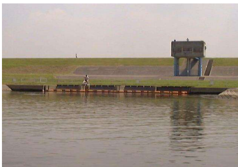
取水口（水道原水の取り入れ口）
