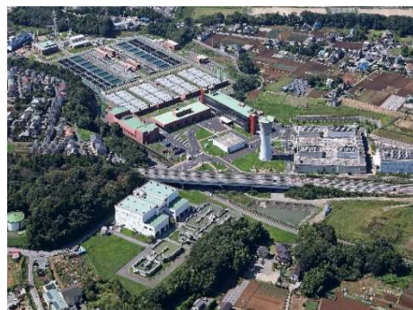
北千葉浄水場(流山市)
