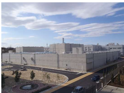
生物活性炭処理施設
