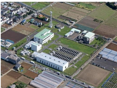
北千葉取水場(松戸市)
