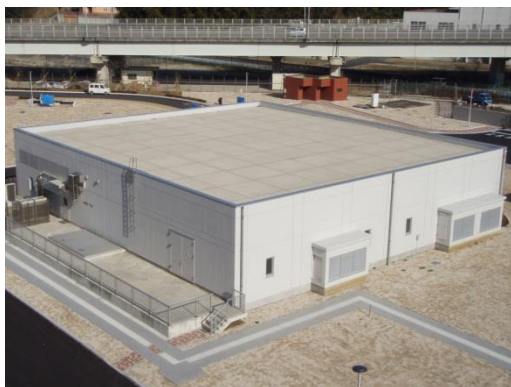
中間ポンプ施設
