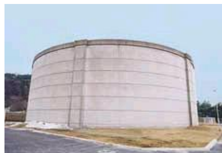
給水地点(構成団体受水槽)
