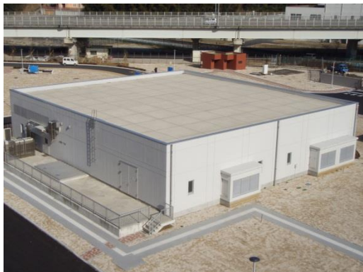
中間ポンプ施設
