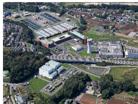
北千葉浄水場(流山市)
