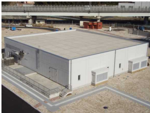
中間ポンプ施設
