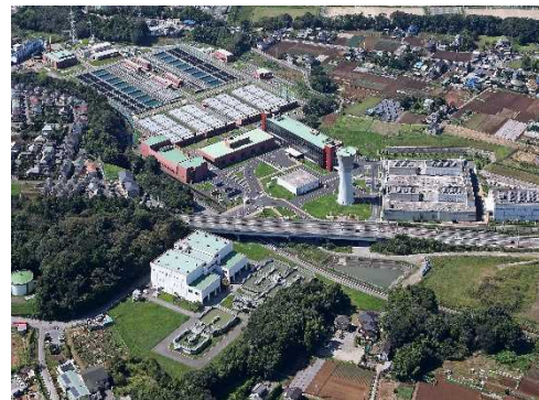
北千葉浄水場(流山市)
