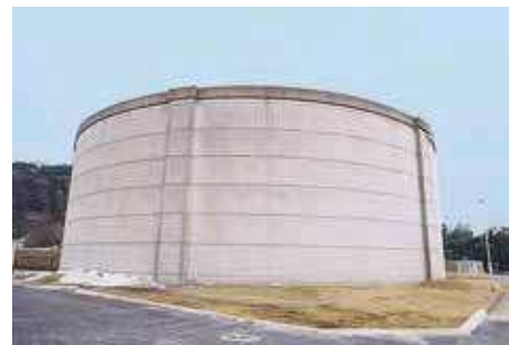
給水地点(構成団体受水槽)
