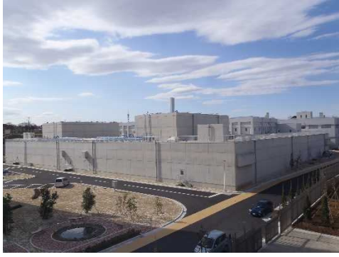
生物活性炭処理施設
