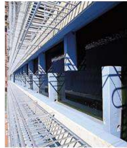
フロック形成池 原水中の濁質分を凝集するため、薬品を添加し攪拌する池で、攪拌機は機械を使わない水まほう流式を採用している。
