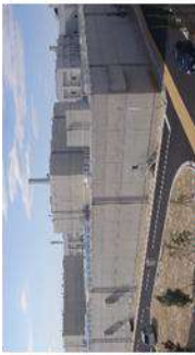
生物活性炭処理施設 オゾンにより分解されなかった有機物を活性炭の層に通して、除去する施設。
