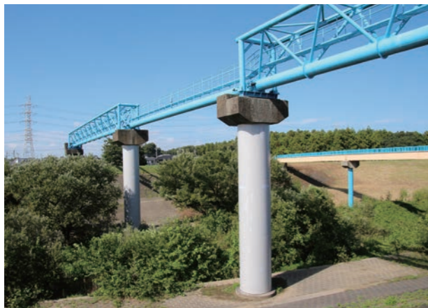
水管橋の耐震補強(橋脚の鋼板巻き)
