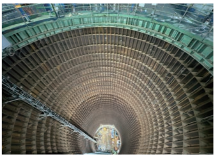
工事中の発達立坑内部
