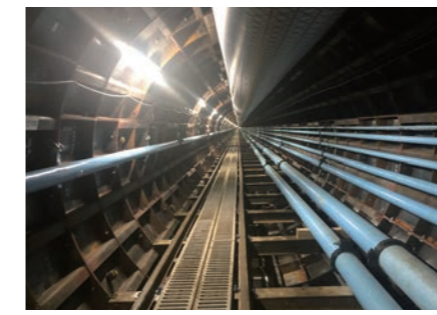
工事中の鋼製セグメント内部
