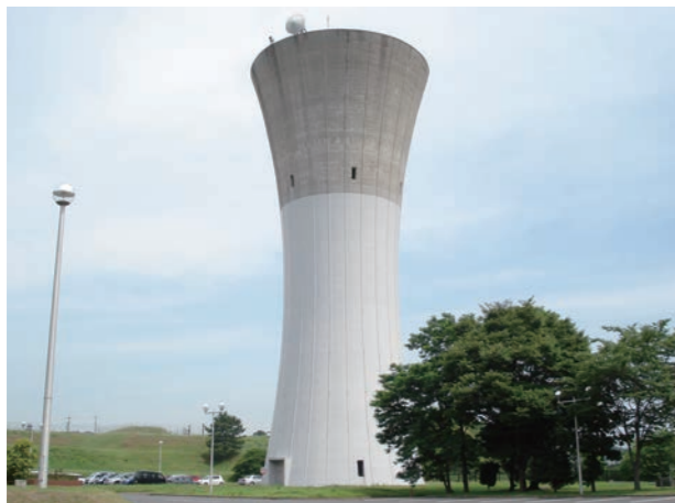
高架水槽の耐震補強(炭素繊維シート貼付)
