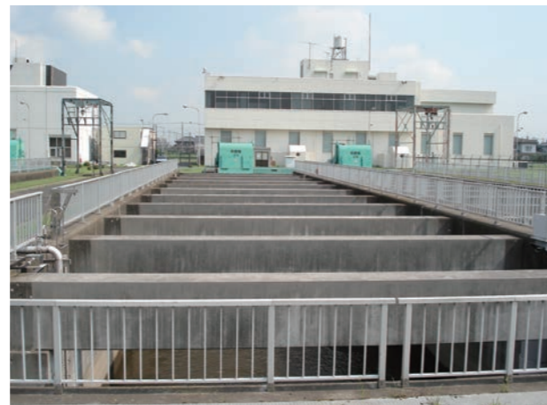
沈砂池の耐震補強(側壁の梁設置)
