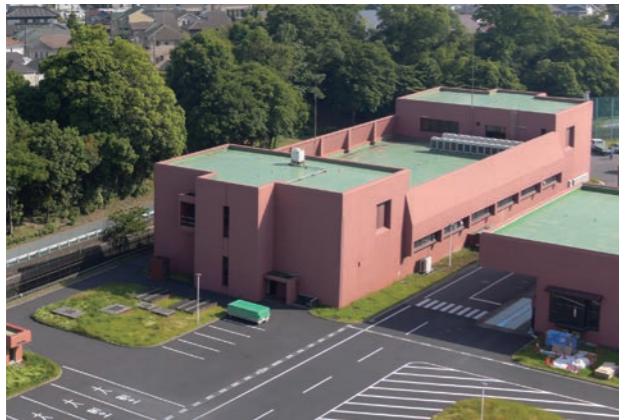
送水ポンプ棟
