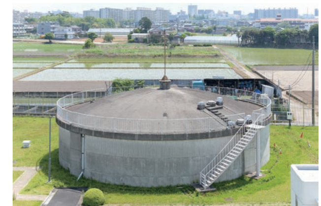
調圧水槽 導水管内の流量が何らかの異常により急激に変化した際に起こる水撃作用による悪影響を緩和します。
