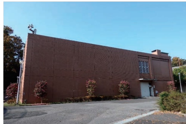
中里中継ポンプ場
