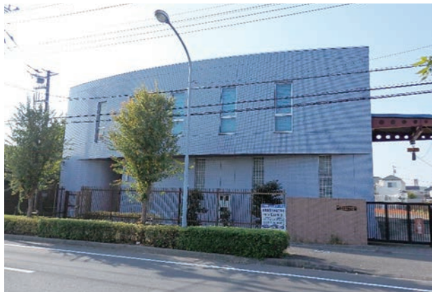
花井中継ポンプ場
