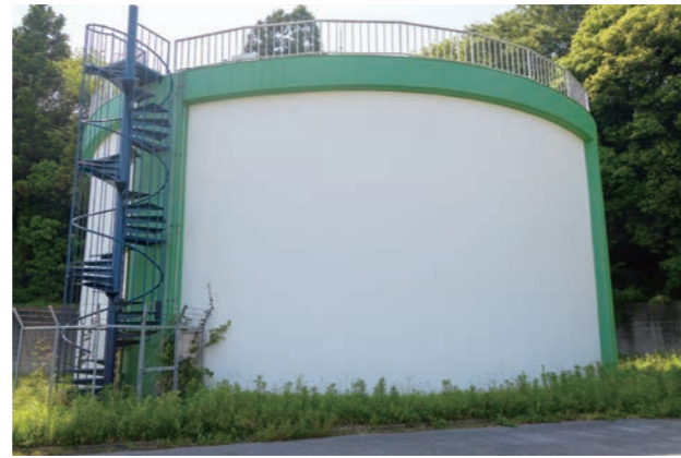
三輪野山調圧水槽
