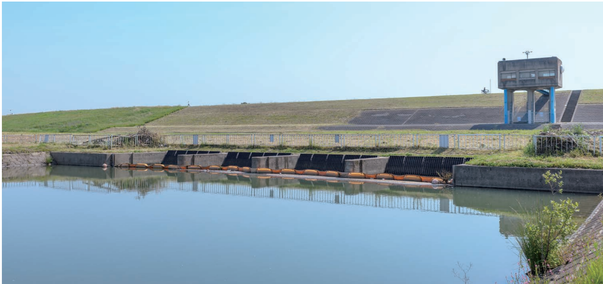
取水口 利根川水系江戸川から河川表流水（原水）を自然流下により取り入れます。
