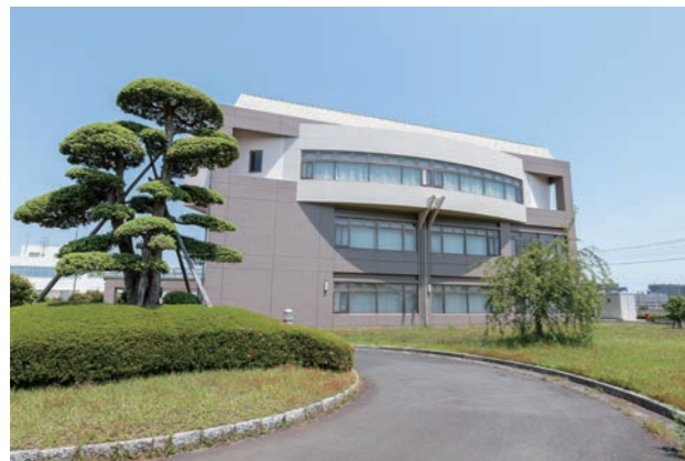
松戸庁舎 企業団の総務部各室の事務室が配置されています。
