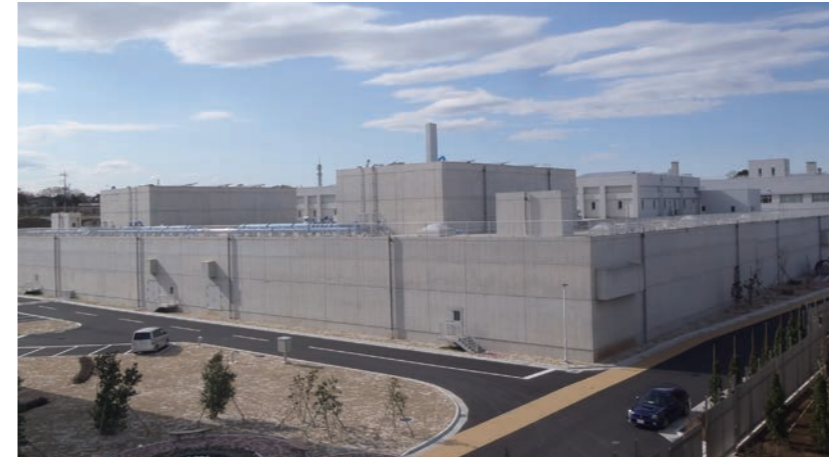
生物活性炭処理施設
