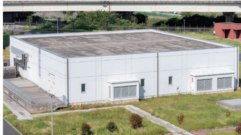
中間ポンプ施設
