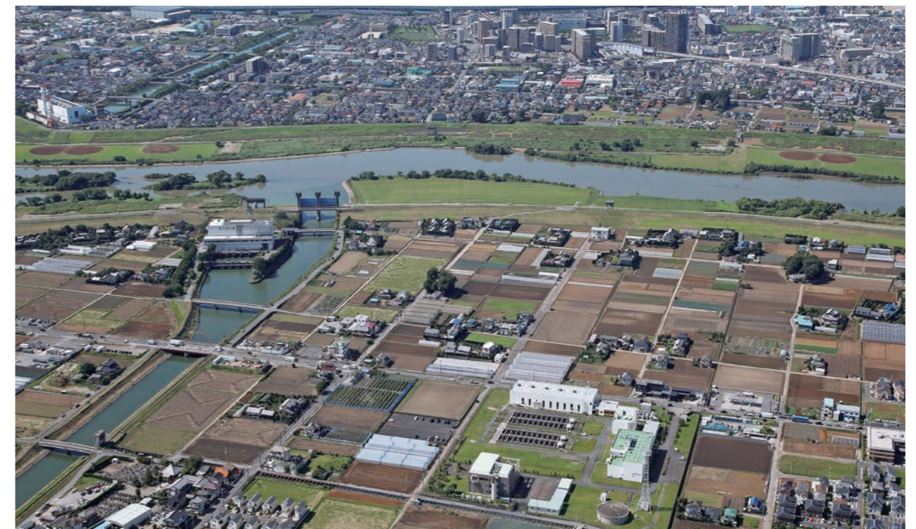
北千葉導水路
