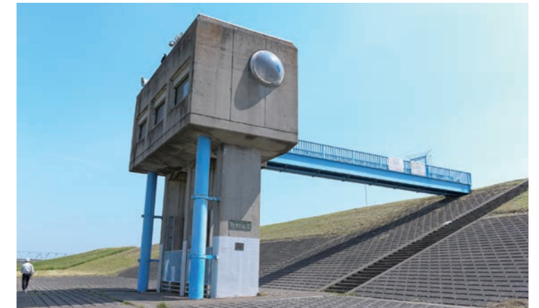
取水門 洪水時の取水流量の調節や水質異常時の取水停止のためのゲート開閉を行う施設で浄水場から遠隔操作できます。
