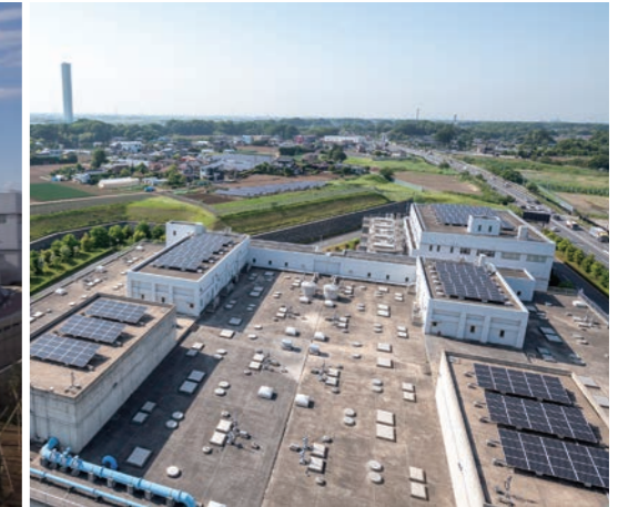
生物活性炭処理施設屋上に設置された太陽光パネル
