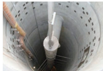
完成したオゾン接触池内部
