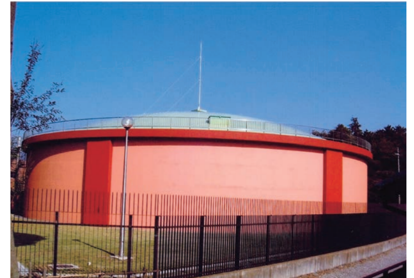
中里調整池設置事業 タンク
