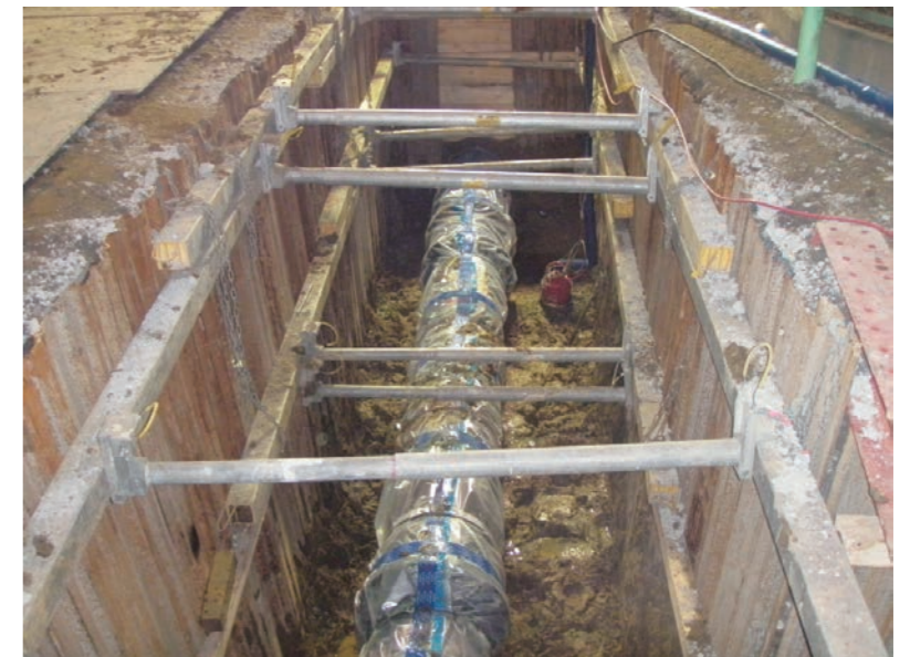
送水管の耐震化
