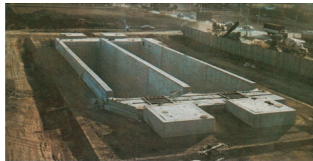
完成した沈砂池 (昭和52年1月)
