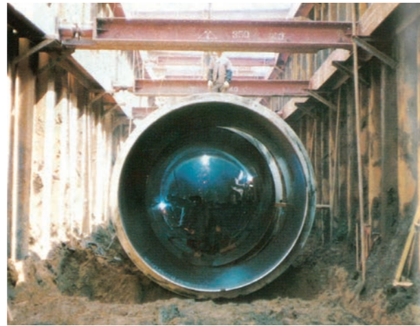
布設中の取水管 (取水口～取水場) φ3200mm (昭和51年4月)
