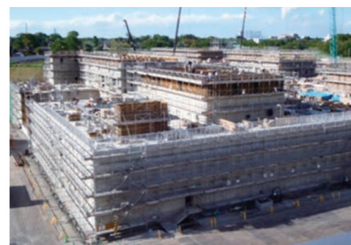
建設中の生物活性炭処理施設 (平成25年5月)
