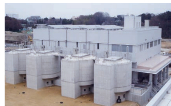
完成したオゾン処理施設 (平成26年3月)
