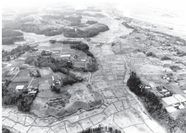
北千葉浄水場用地 (昭和49年3月)
