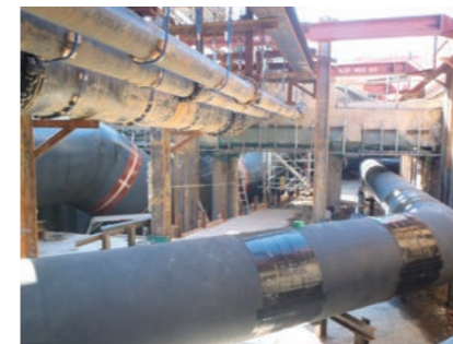
既存施設の合間を縫った場内連絡管の布設工事
