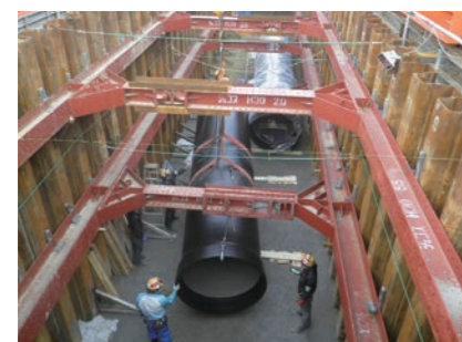
流出管 ダクタイル鋳鉄管φ1,200～1,800mm
