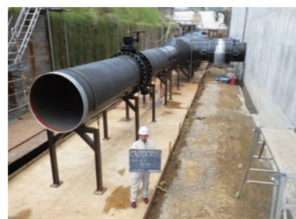
流入管 鋼管φ1,200～2,000mm
