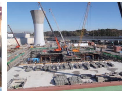
建設中の中間ポンプ施設 (平成25年12月)
