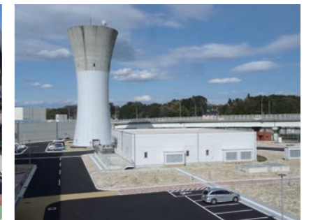
完成した中間ポンプ施設 (平成26年9月)
