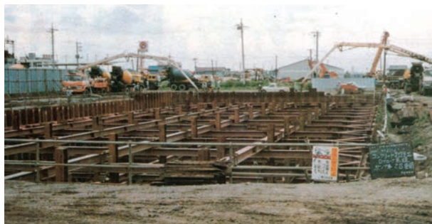
建設中の沈砂池 (昭和51年6月)
