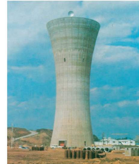
完成した高架水槽 (昭和53年11月)
