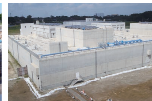
完成した生物活性炭処理施設 (平成26年3月)
