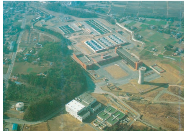
北千葉浄水場 (昭和63年3月)
