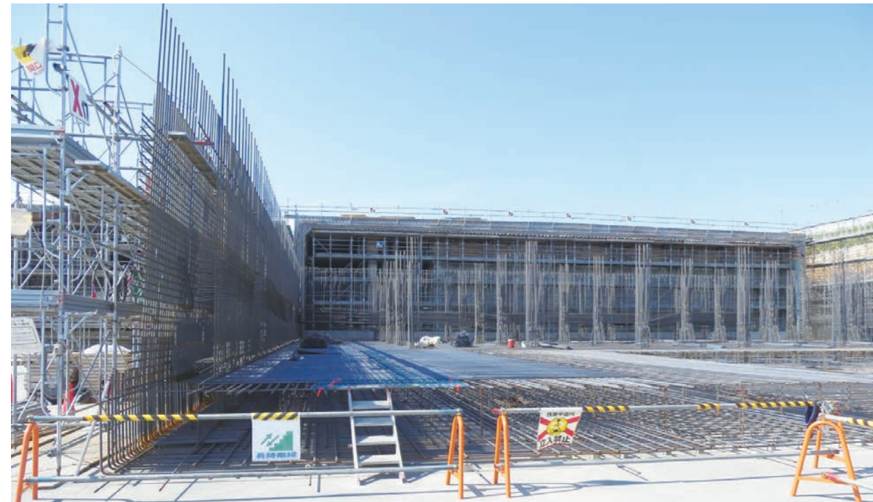
建設中の調整池（平成28年11月）
