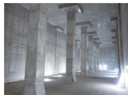
完成した調整池内部（平成30年3月）
