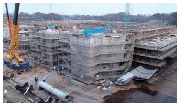
建設中のオゾン処理施設 (平成25年2月)
