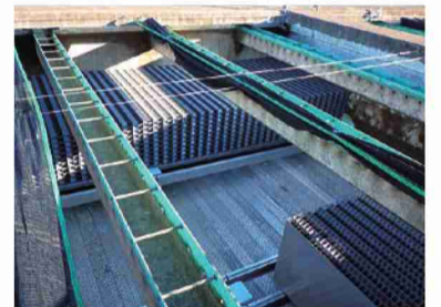
4系沈澱池沈降装置等更新工事
