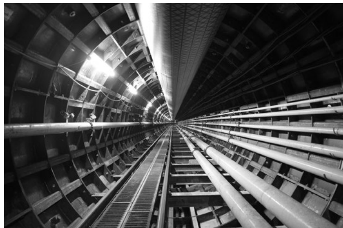
導水管更新事業を推進（管布設前のトンネル内部）
