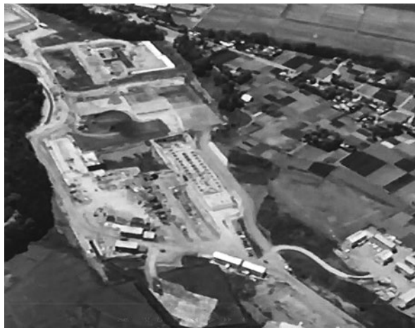
浄水場建設中のようす
