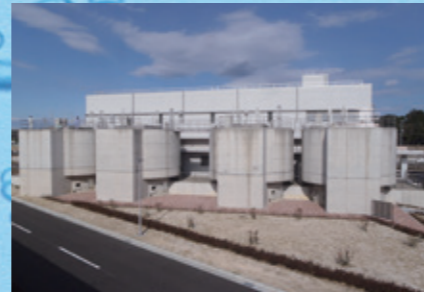
オゾン処理施設 オゾンを注入し、オゾンの強力な酸化力により有機物を分解する施設。
