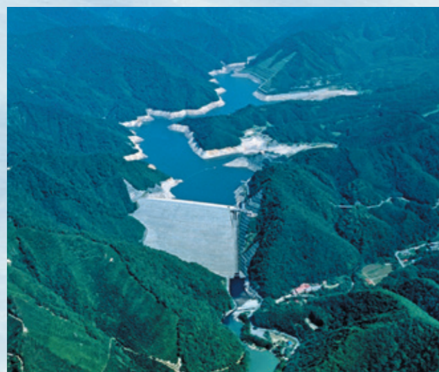
奈良俣ダム 提供：独立行政法人水資源機構
