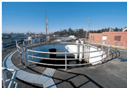
着水井 取水場から導水された原水の水位などを調節する施設。
