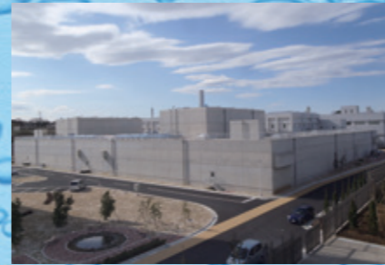
生物活性炭処理施設 オゾンにより分解された有機物を活性炭の層に通して、除去する施設。
