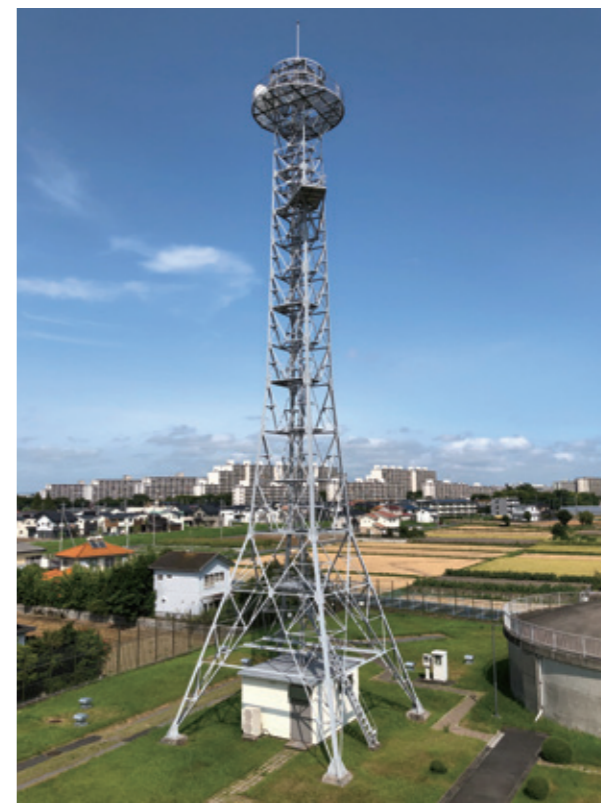
固定無線設備
