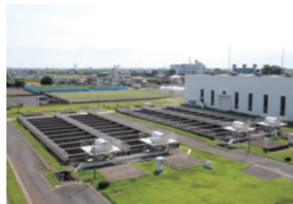
沈砂池 原水とともに流入してきた粒子の大きな砂質分を沈降させる池。
