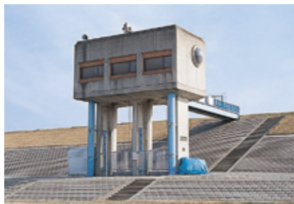
取水門 河川洪水時の流量調節や水質異常時の取水停止のためのゲート開閉を行う施設。
