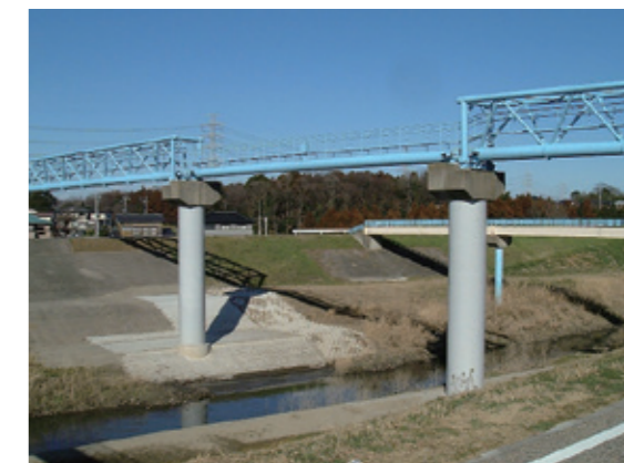
利根運河水管橋
