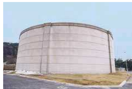
給水地点(構成団体受水槽)
