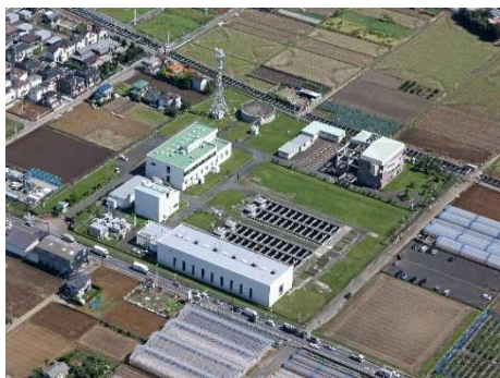
北千葉取水場(松戸市)
