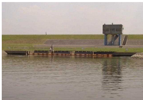
取水口(水道原水の取り入れ口)
