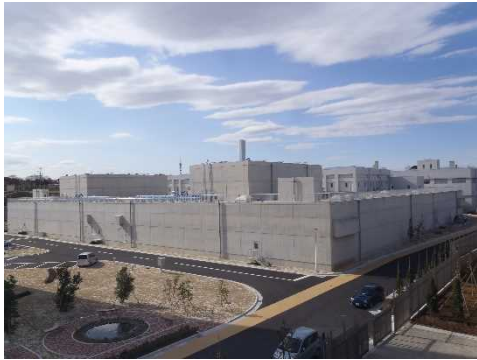
生物活性炭処理施設
