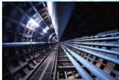
(約5kmのトンネル内部)
