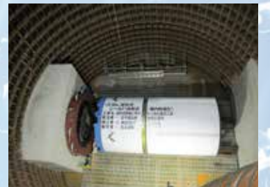
(シールドマシン 直径約3m)
