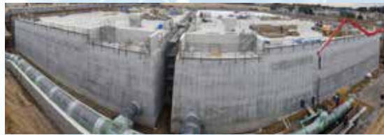
(建設中の全景)
