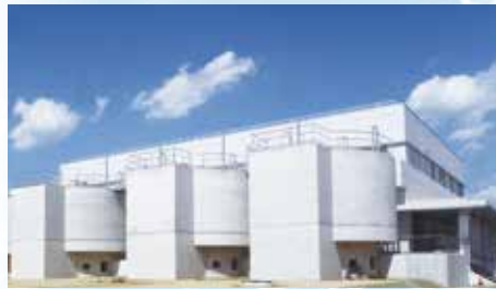
オゾン処理施設 (色やにおいのもととなる有機物を分解)
