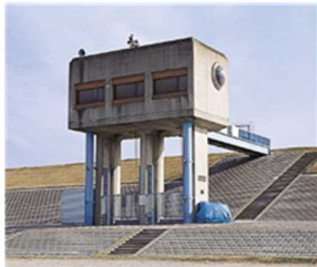
取水門 河川洪水時の流量調節や水質異常時の取水停止のためのゲート閉鎖を行う施設で、浄水場から遠隔操作できる。
