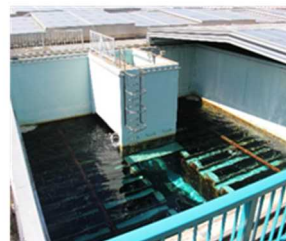
急速ろ過池 濁質分を除いた水を飲み水とするため、砂ろ過層を通過させ浄水する池。
