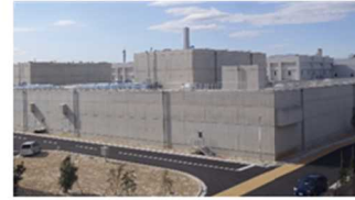
生物活性炭処理施設 オゾンにより分解された有機物を活性炭の層に通して、除去する施設。
