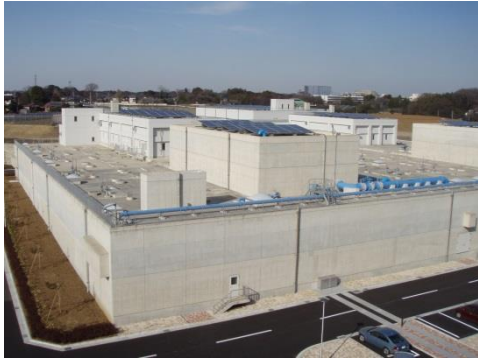
生物活性炭処理施設
