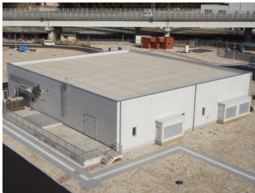
中間ポンプ施設
