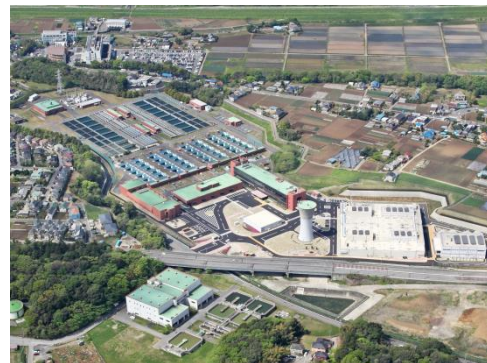
北千葉浄水場(流山市)
