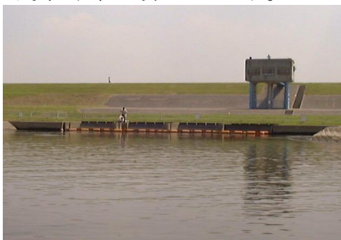
取水口(水道原水の取り入れ口)
