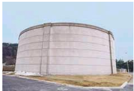
給水地点(構成団体受水槽)
