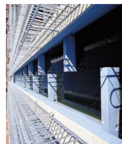
フロック形成池 原水中の濁質分を凝集するため、薬品を添加し攪拌する池で、攪拌機は機械を使わない水平流式を採用している。
