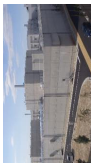
生物活性炭処理施設 オゾンにより分解された有機物を活性炭の層に通して、除去する施設。
