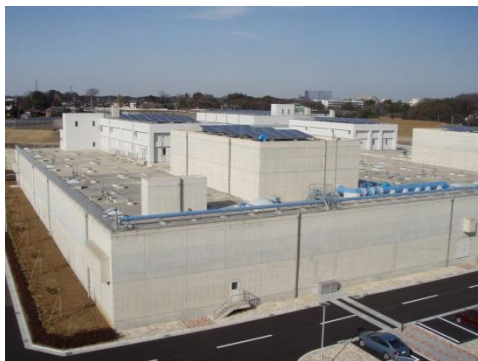
生物活性炭処理施設
