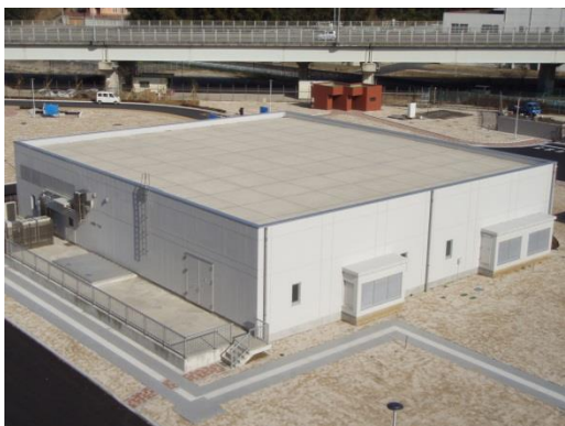
中間ポンプ施設
