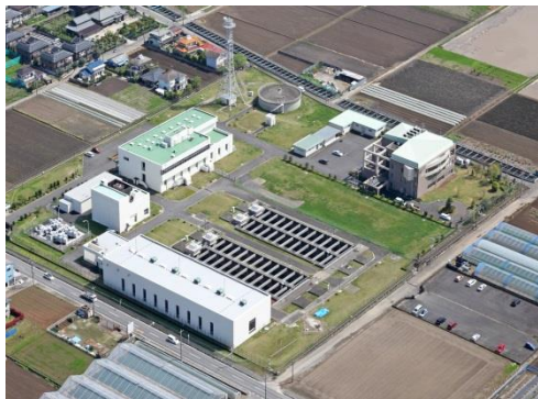
北千葉取水場(松戸市)
