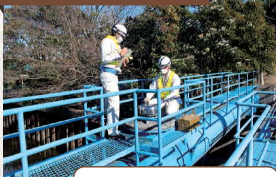
送水管路の点検
