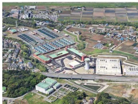
北千葉浄水場(流山市)
