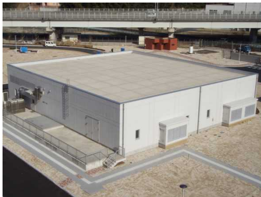
中間ポンプ施設
