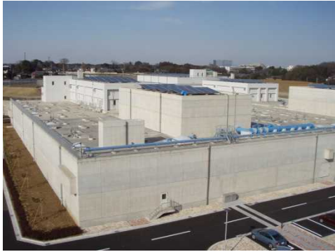
生物活性炭処理施設
