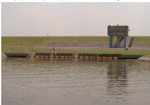
取水口(水道原水の取り入れ口)
