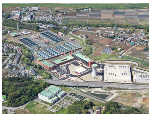
北千葉浄水場(流山市)
