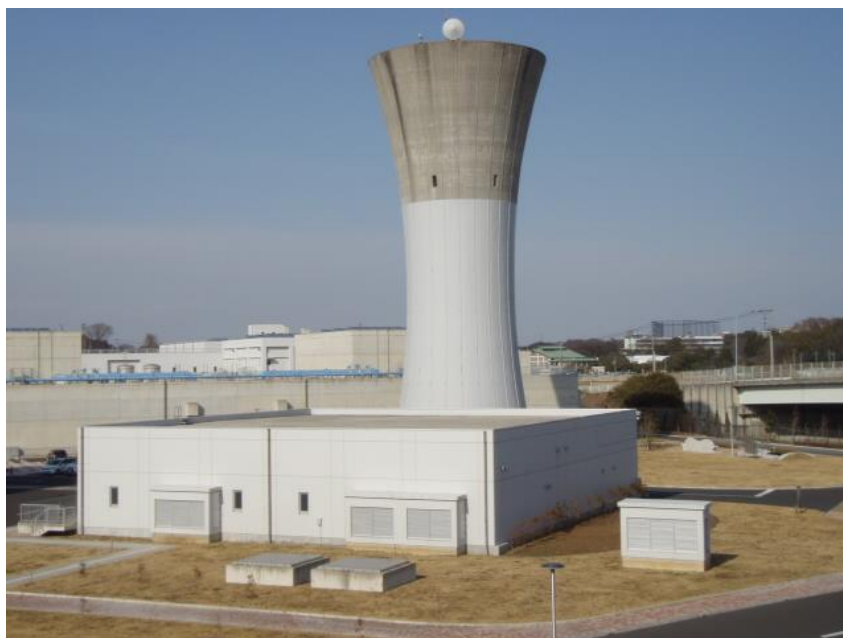
北千葉浄水場「中間ポンプ施設及び高架水槽」
