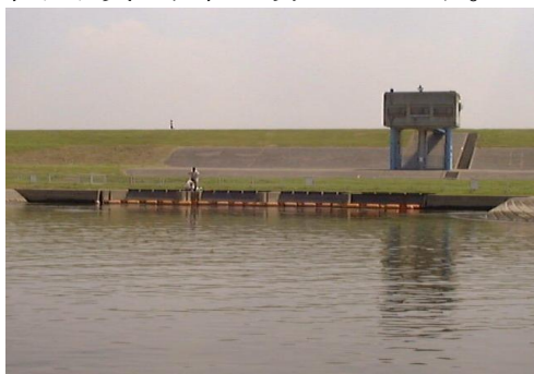
取水口（水道原水の取り入れ口）
