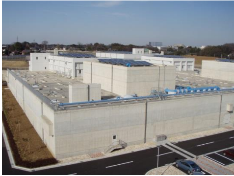
生物活性炭処理施設
