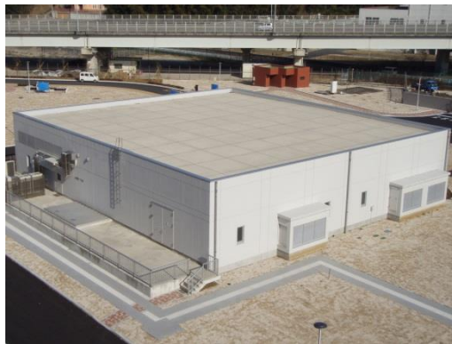
中間ポンプ施設
