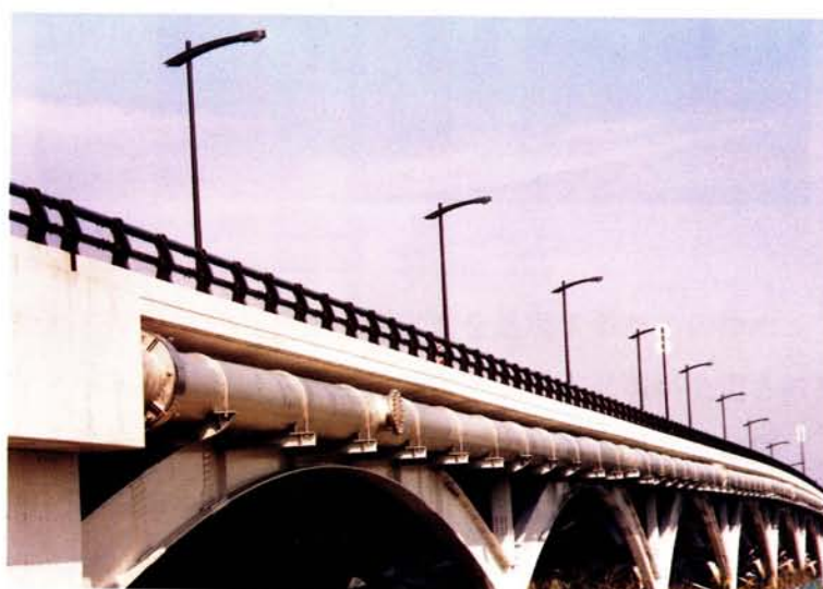
ループ化事業による手賀大橋添架管
