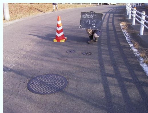
管路点検の実施状況
