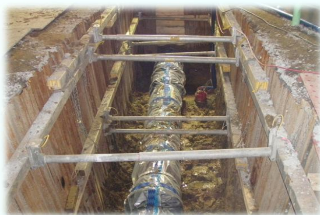
管路更新の状況
