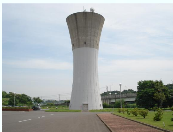
高架水槽の耐震補強（炭素繊維シート貼付）
