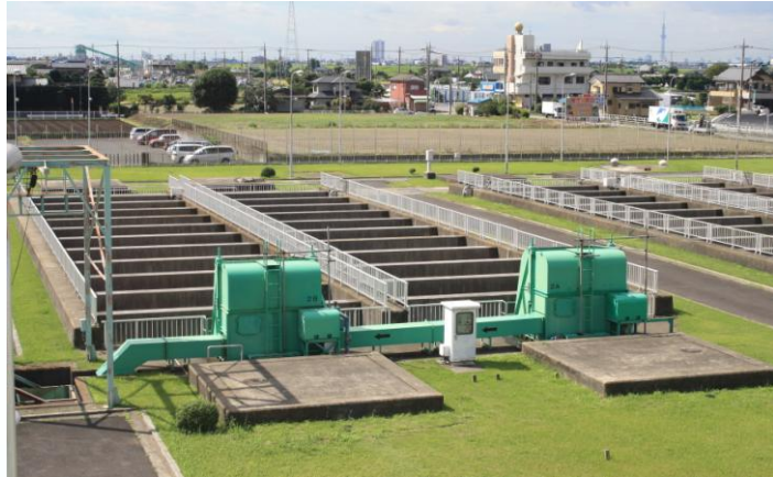
沈砂池の耐震補強（側壁の梁設置）
