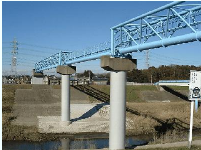
水管橋の耐震補強（橋脚の鋼板巻き）
