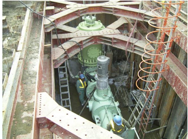
不断水分岐管製作接合工事
