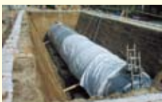
耐震性貯水槽設置工事
