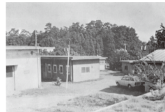
昭和40年代の小金浄水場
