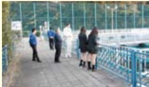
沈でん池を見学
