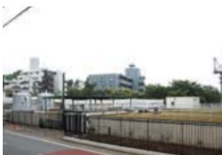
現在の常盤平浄水場
