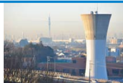
北千葉浄水場高架水槽と東京スカイツリー この写真は、流山おおたかの森高校から提供していただきました。
