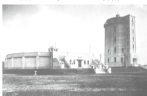
完成直後の千葉高架水槽と配水池
