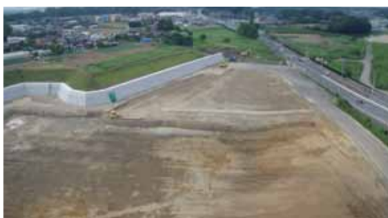
造成工事の様子
