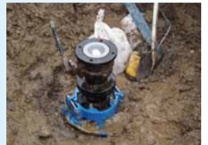
沼南・我孫子線 フランジ補強金具による補修(柏市若白毛地先)
