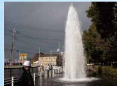
関宿線 補修弁破損(流山市上新宿地先)
