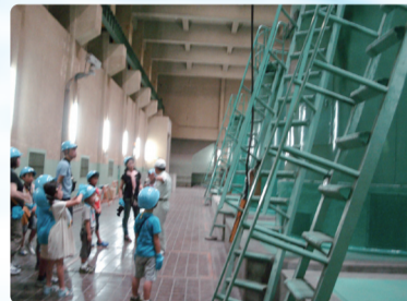
取水場の見学(取水ポンプ棟)
