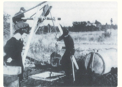
第1水源池第1号井の掘削工事 昭和29年
