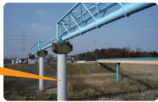
利根運河水管橋(流山市内)
