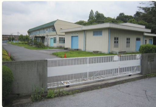
上花輪浄水場
