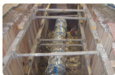
耐震管への布設替(野田市内)
