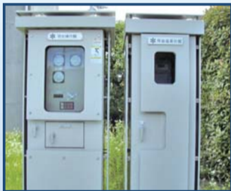
連続自動水質監視装置 構成団体受水槽の水質を常時監視しています。
