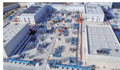
場内連絡管 既設管の合間をぬって、大口径管(口径2,400mm)等の布設を進めています。
