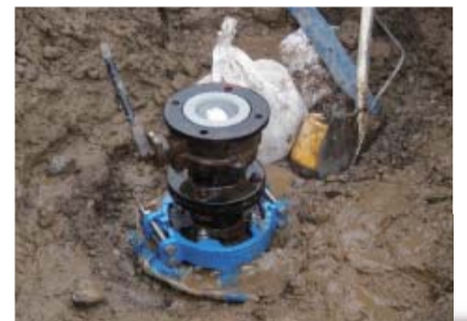
損傷した空気弁接合部の補修
