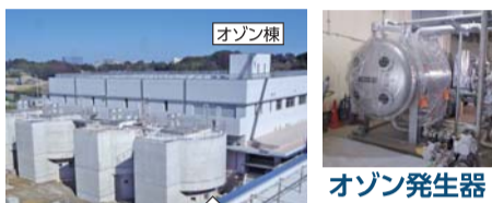
②オゾン処理施設 オゾン発生器など機械設備の据え付けが進んでいます。
