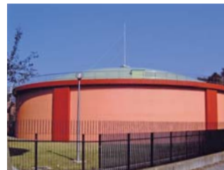
中里調整池の設置(H12) 関宿線の途中に調整池を設置 (貯留能力10,000m 3 )
