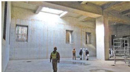
①中間ポンプ施設 水槽の枠組みが出来上がりました。
