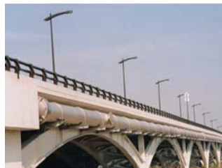
送水管路の環状化(H14) 我孫子線と柏線を結ぶ連絡管を布設 (口径：900mm 延長：約9km)
