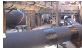
場内連絡管 既設管の合間をぬって、大口径管(口径2,400mm)等の布設を進めています。
