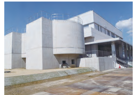
完成したオゾン処理施設
