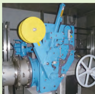
送水管 (関宿線) 途中の中里調整池の緊急遮断弁
