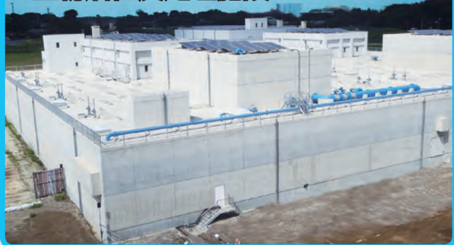
生物活性炭処理施設
