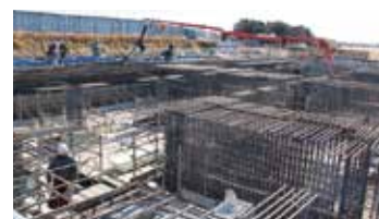
沼南調整池築造工事
