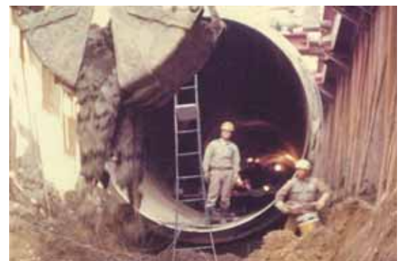
北千葉取水場 取水管布設工事の様子 (昭和51年当時)
