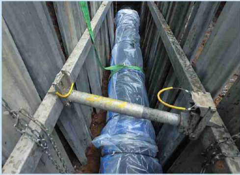
耐震管(ダクタイル鋳鉄管口径500mm)を布設したところ
